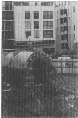
Aqueduc Médecis en cours de destruction et de morcellement sur le chantier de la Zac Alésia-Montsouris, avril 2001.
