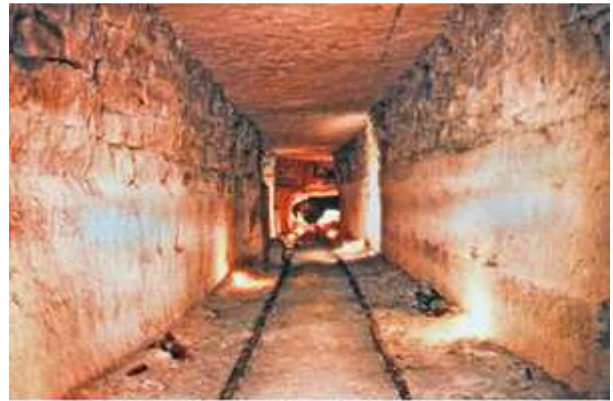
Voie ferrée dans la galerie principale longueur de voie 100 m écartement 1m
