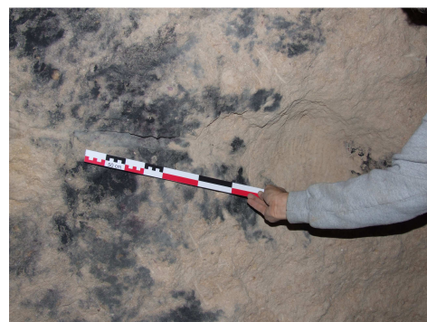
Fig. 1 : Traces de poudre noire en ciel de carrière
