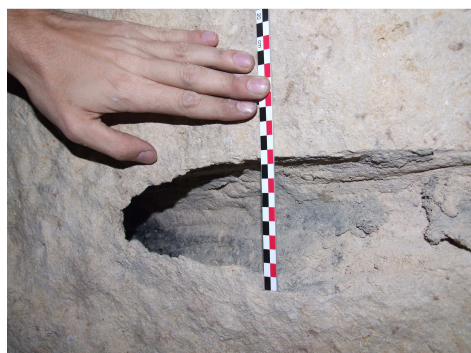
Fig. 3 : Trou de mine réalisé à l'aiguille
