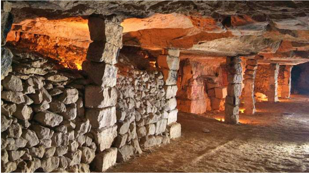
Consolidation par "hague et bourage" (carrière de Bougival)
