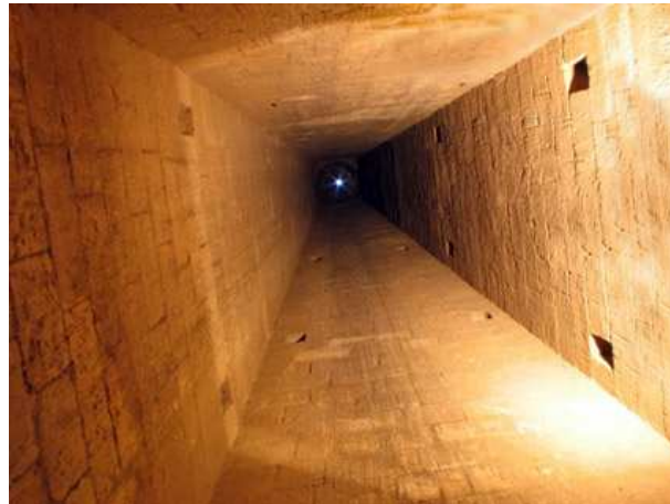
Puits avec à la base une coupole dont la fonction reset inconnue! Ancien puits d'extraction réaménagé en puits d'inspection trpézoïdal (carrière des capucins)
