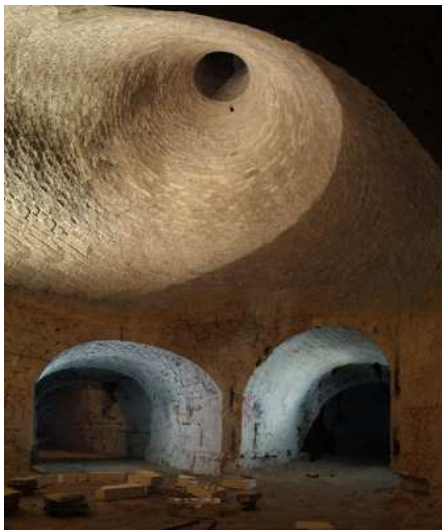
Puits avec à la base une coupole dont la fonction reset inconnue! Ancien puits d'extraction réaménagé en puits d'inspection trpézoïdal (carrière des capucins)
