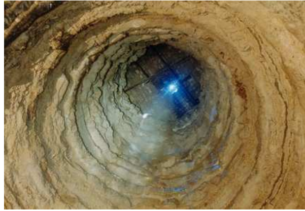
Puits en plaine masse ( photo superflux)
