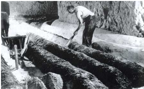
Gobetage réalisé avec une taloche (carrière de Chavenay)
