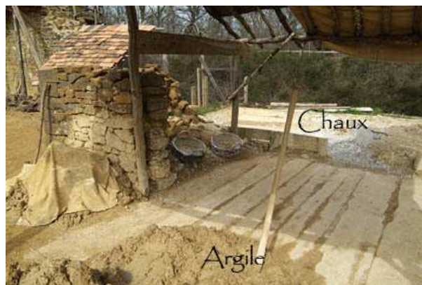
Préparation du mortier à base de chaux de façon traditionnelle
