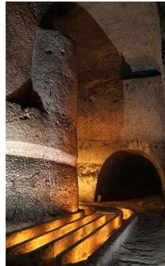
Goulotte de décantation dans la carrière "des Lions"
