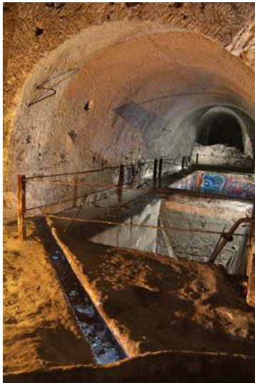
Bassins de décantation dans la carrière "des Lions"
