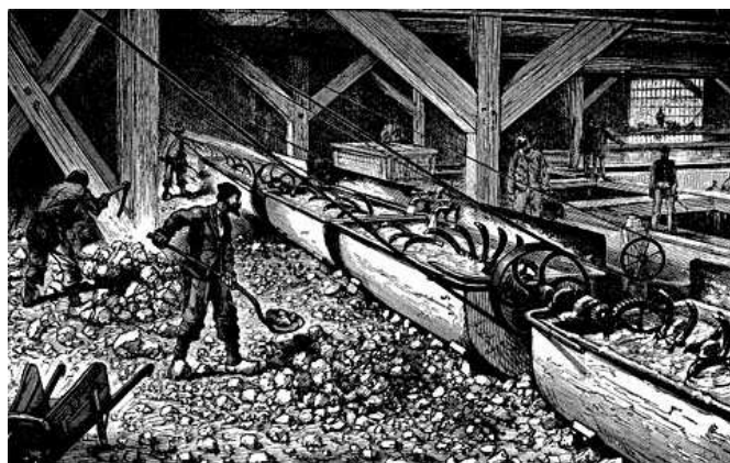
Barboteurs mécaniques organisés sur une rangée de 25m.
