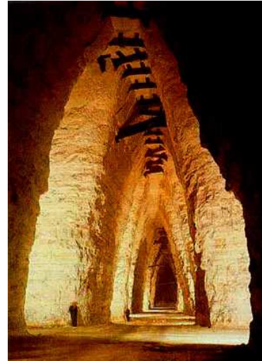
Renfort du ciel avec des "brindilles" (photo Baranger coll. IGC)
