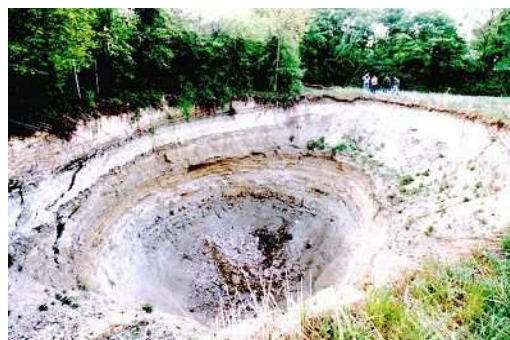
Fontis ayant atteint la surface (photo IGC)
