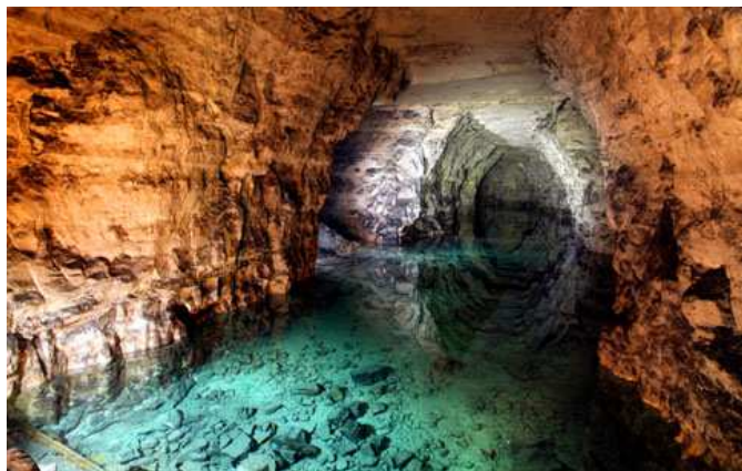
Galerie inondée du fait des infiltrations par les fontis
