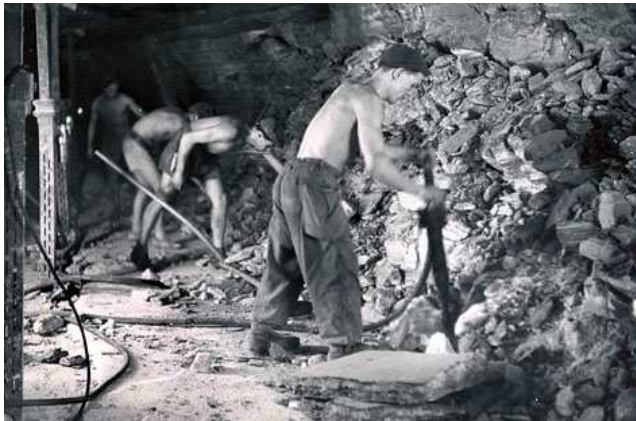
Utilisation du marteau pneumatique (source : Géopolis)
