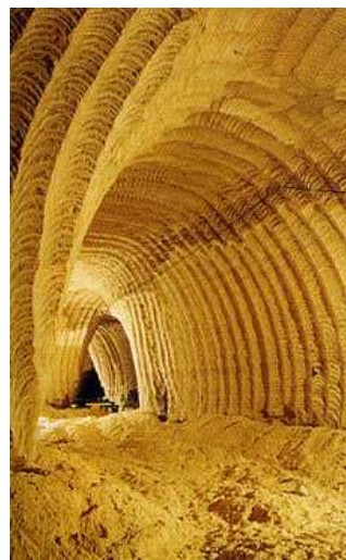
Galerie retaillée afin consolider la voûte avant leur comblement par bulldozers à Rosny-sous-bois (photo E. Gaffart)
