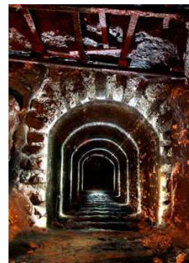
Galerie de roulage avec une voûte maçonnée
