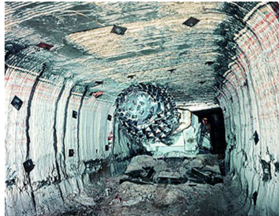
Haveuse circulaire ou fraise à bras (source: Géopolis)
