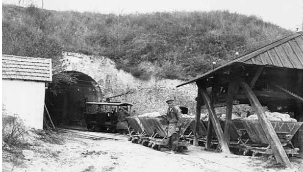
Entrée d'une carrière de gypse avec des wagonnets basculeurs et le locotracteur diesel (source: Derelicta, coll. M.Pécé)
