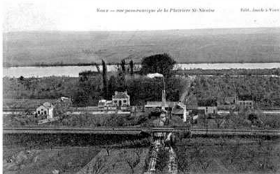
Usine à plâtre "Saint-Nicaire" de Vaux-sur-Seine
