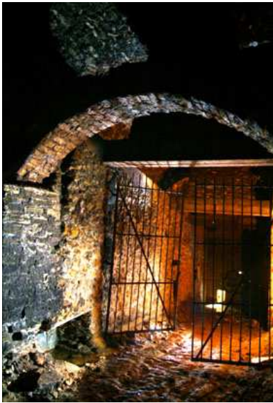
Cavage fermé de la galerie inférieure dans le gypse tendre
