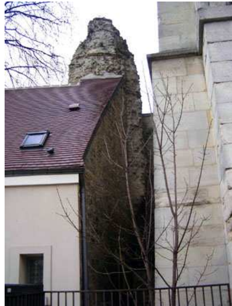
Reste de pilier (photo: Tai)
