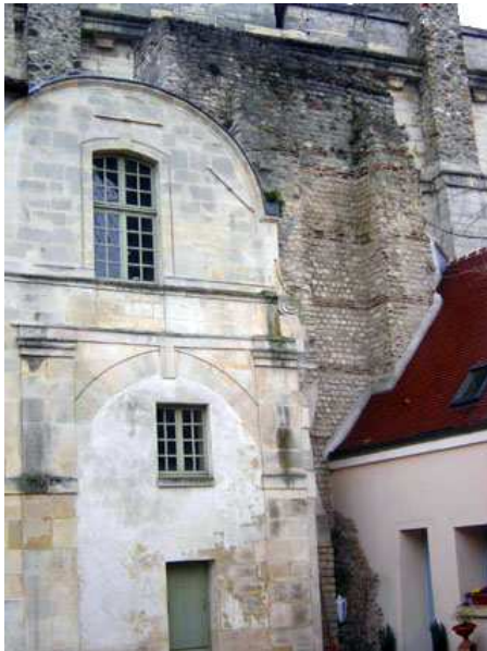
Reste de pilier (photo: Tai)
