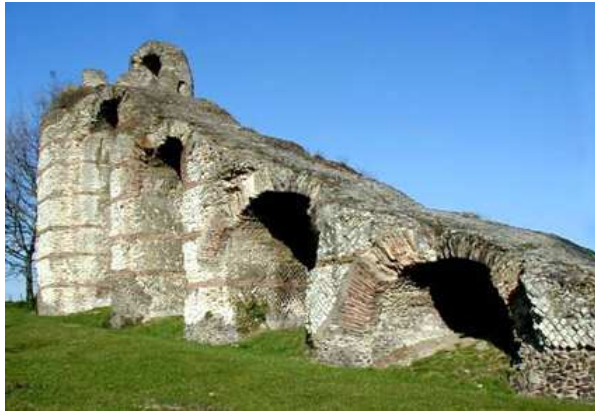
Restes des arcs du pont-siphon gallo-romain du Gien (chaponost)
