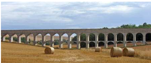
Un des pont-aqueduc de la Vanne
