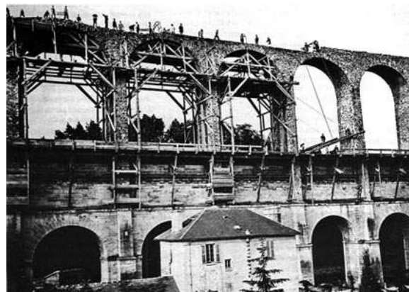
Construction du pont-aqueduc de la Vanne sur celui de Médicis à Arcueil (Photo Collard)
