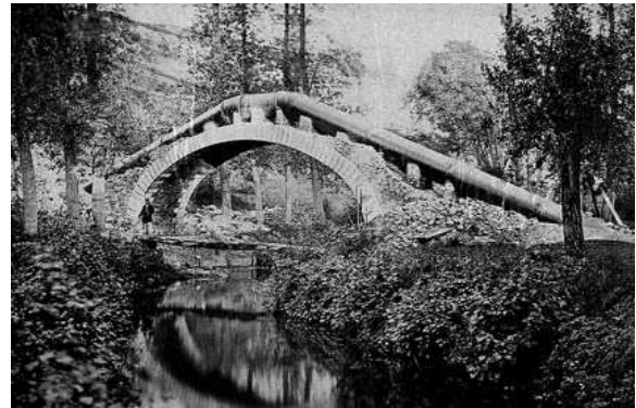
Pont-siphon sur un affluent de la Marne (aqueduc de la Vanne)
