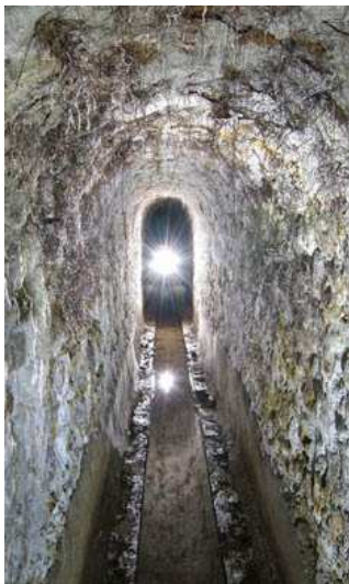
Aqueduc dans une rigole
