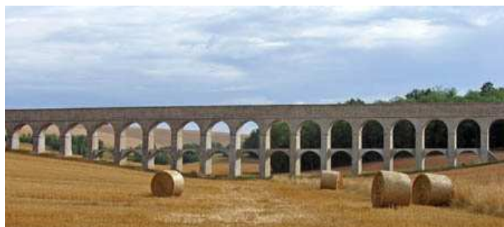
Un des ponts aqueduc de l'aqueduc de la Vanne
