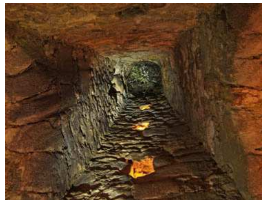
Vue de dessous d'un puisard
