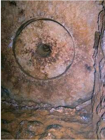
Tampon de pierre
