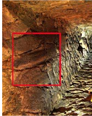
Traces d'usure des pierres par la corde
