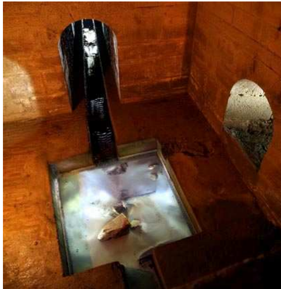
Regard IV avec la galerie à droite qui apportait l'eau à l'ancien château de Berny.
