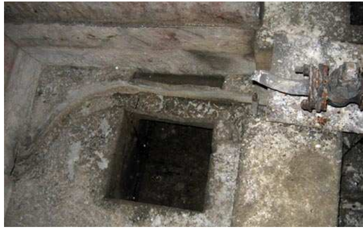
Tuyau de dérivation cassé et rigole qui alimentaient successivement une concession privée
