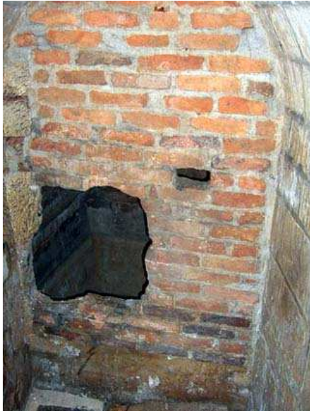
Cuve d'un réservoir d'eau privé
