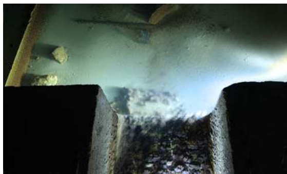
Calcite déposée dans un bassin de décantation
