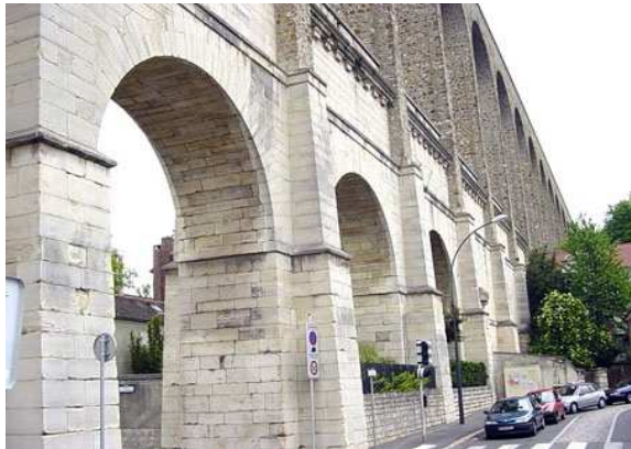
Pont-aqueduc Médicis dans la partie basse (Arcueil)
