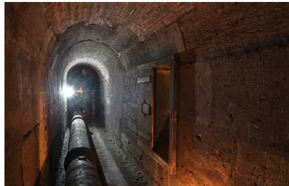
Galerie du pont-aqueduc avec un volet en premier plan
