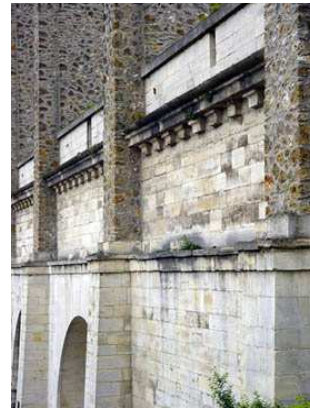
Pont-aqueduc Médicis (Arcueil)
