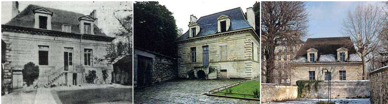
Face sud Maison du fontainier en 1901 ----- Face nord de la maison du fontainier vers 1990 ----- Face sud après la restauration qui débuta en 1996
