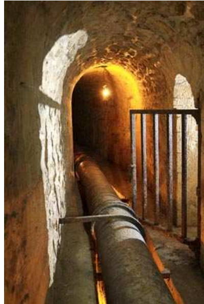
Portion de l'aqueduc en conduite forcée
