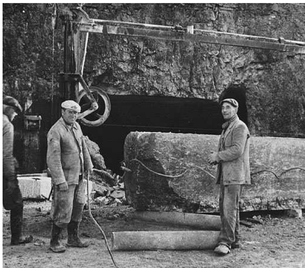
Roules permettant de déplacer le bloc en arrière plan (Carrière de marbre)
