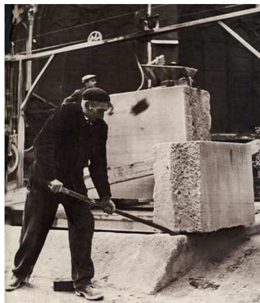
Déplacement d'un bloc de marbre à l'aide d'une petite barre de carrier
