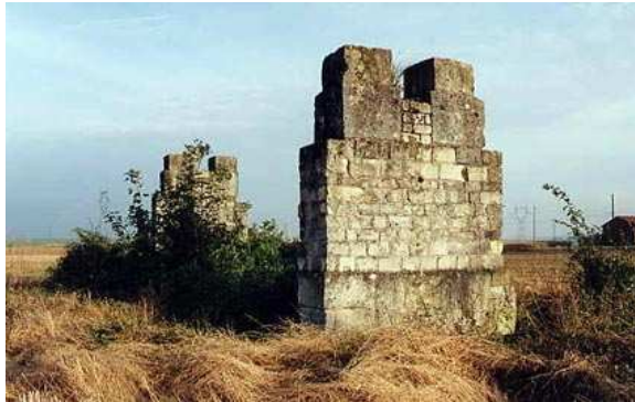
Ruine de treuil de Verberie ( photo francis Cahuzac)
