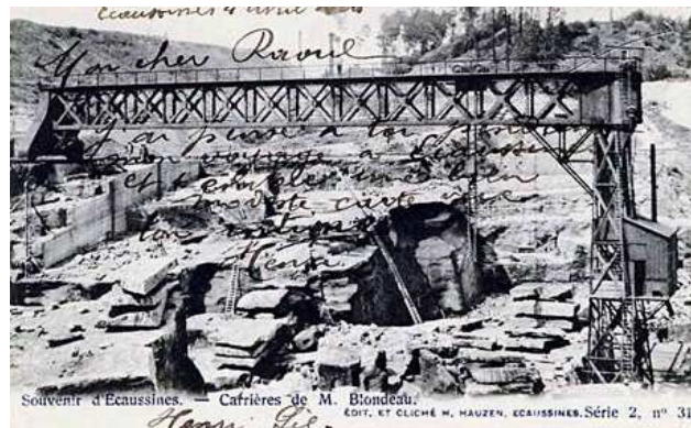
Treuil, de type pont roulant, au dessus d'un puits (Ecaussinnes)
