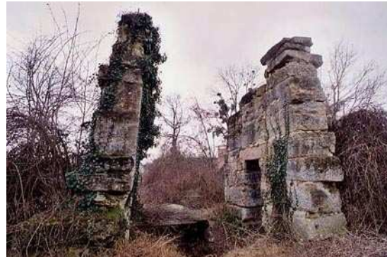
Ruine du treuil de Marly-la-ville ( photo francis Cahuzac)
