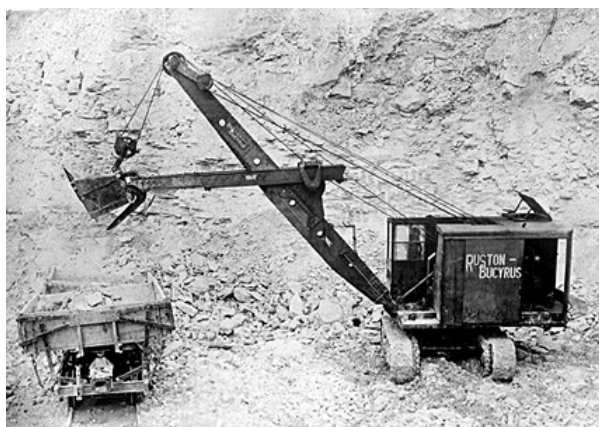
Chargement de plâtre dans un wagonnet-girafe
