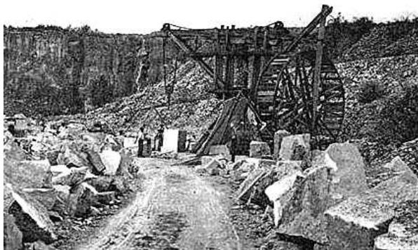
Grue manuelle à roue en bois (Triel-sur-Seine)
