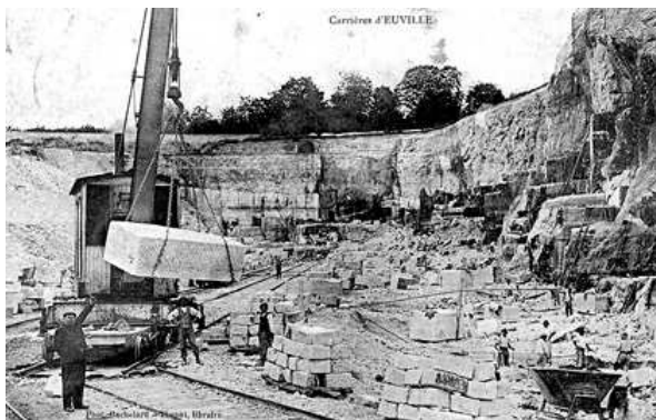
Grue à vapeur déplaçant un bloc (Euville)
