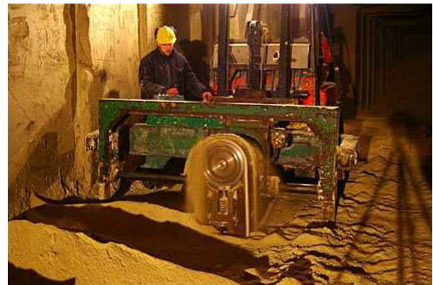
Trnchage direct du sol de carrière (photo Tchorski)
