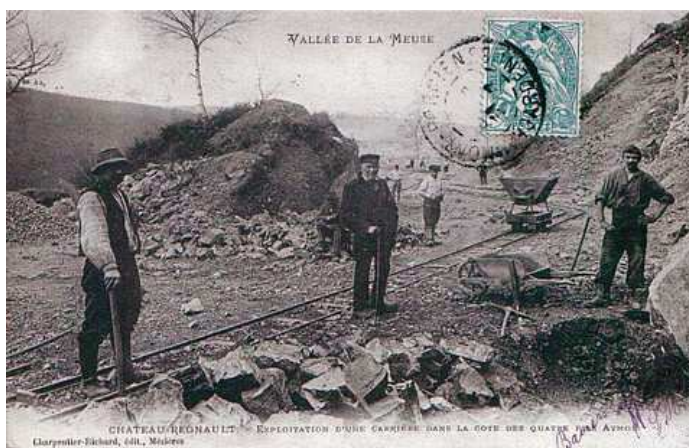
Voie étroite dans une carrière à ciel ouvert (vallée de la Meuse)
