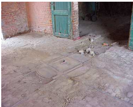
Plaque tournante encore en place dans une ancienne usine de briques
